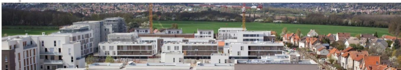
L'écoquartier de Clause Bois-Badeau en construction
