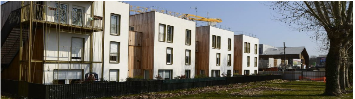
Les Docks de Ris en chantier
